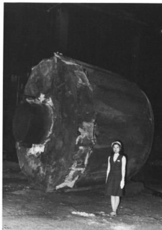
Рисунок 1.36 - Общий вид полого слитка для изготовления трубной поковки
